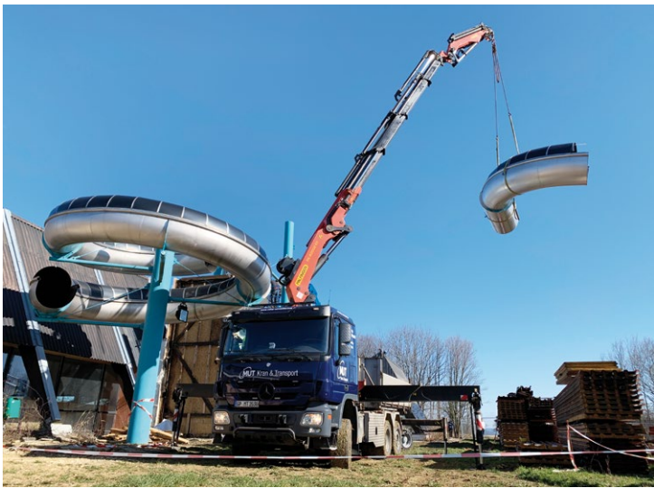
Demontage und Transport einer Wasserrutsche mit MUT-Ladekran nach Leipzig zum Wiederaufbau.
