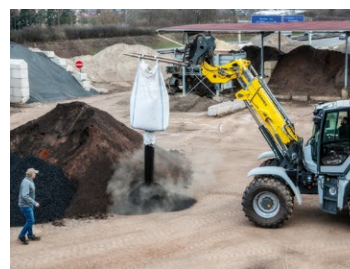
Ein Radlader schüttet Muttererde, Pflanzenkohle und Phosphor zusammen.
