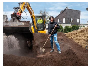
Mit Bagger und Schaufel: Das Gartensubstrat muss gleichmäßig verteilt werden.
