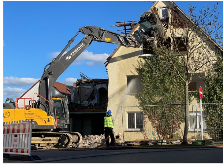
Ein Spezialgebiet der Firma Vybiralik sind Abbrucharbeiten.
